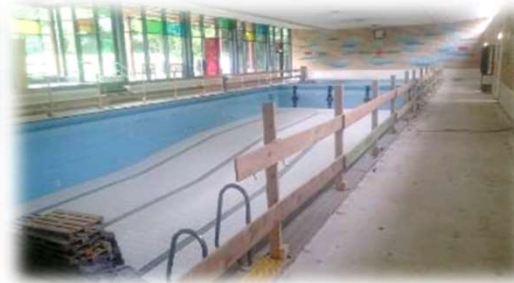
Ein Blick in die Schwimmhalle nach den Sanierungsarbeiten. Der Boden ist neu gefliest worden.
