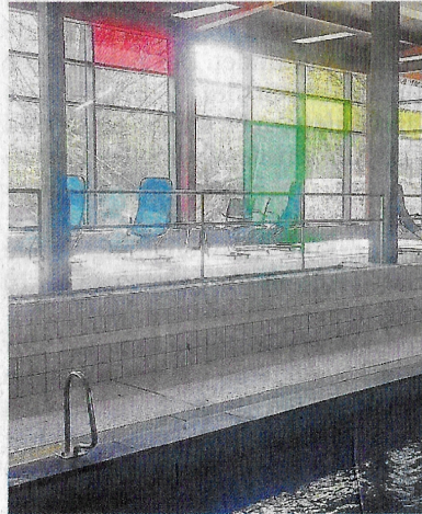
Die Fensterfront des Bades wurde bereits erneuert.
